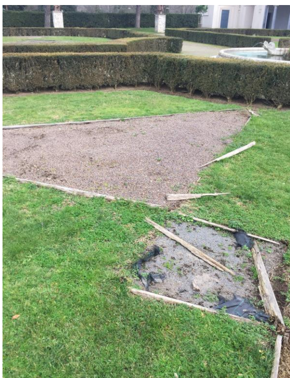
Image n. 4 : Etat actuel des motifs Peduzzi : bordure en bois délabrées, manques de matériaux dans certaines figures, lecture difficile de la géométrie des motifs.
